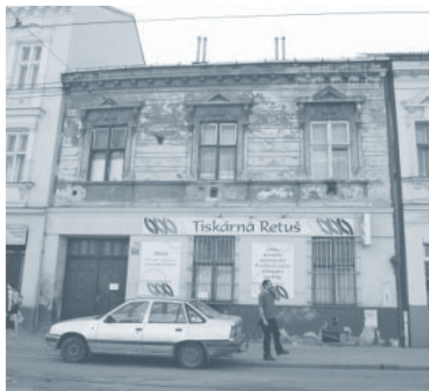
Připravujeme rekonstrukci objektu Vranovská 45, kde od roku 2012 zahájíme činnost Centra integračních služeb pro klienty.
